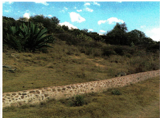
Canal conocido como apantle, mediante el cuales se transportaba el líquido que corría por el acueducto.
