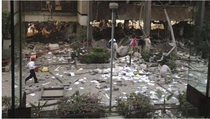
Figura 1 Explosión en las oficinas de PEMEX en 2013
