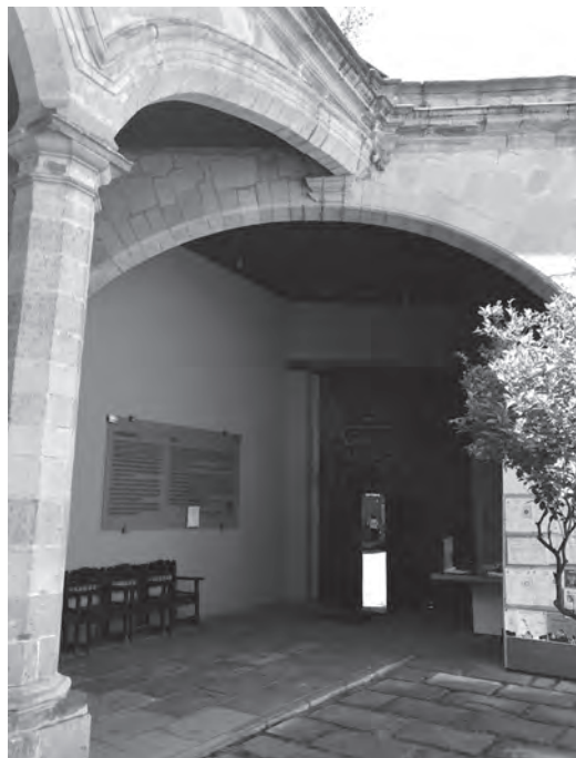
Figura 7 Detalle del arco paralelo al ochavo del acceso (Foto: A. Contreras)
