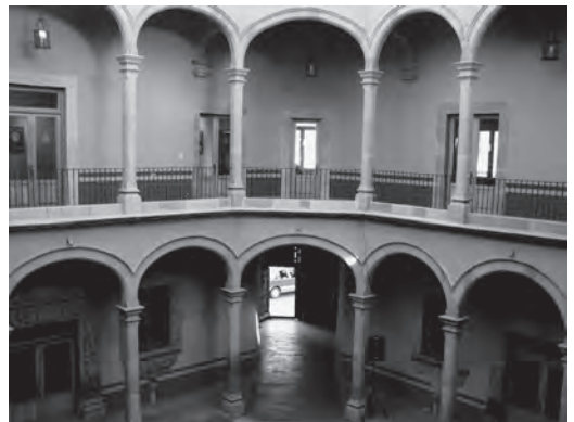
Figura 10 Detalle de la esquina del claustro con la solución de liga entre los arcos (Foto: A. Contreras, 2017)
