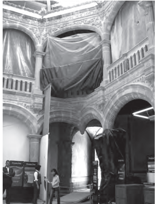
Figura 14 Detalle del arco con clave colgante (Foto A. Contreras, 2009)
