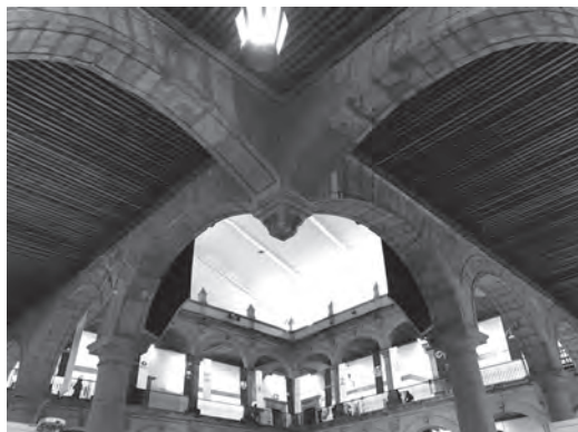
Figura 3 Solución de la esquina ochavada con la intersección del doble arco rampante (Foto: A. Contreras 2019)
