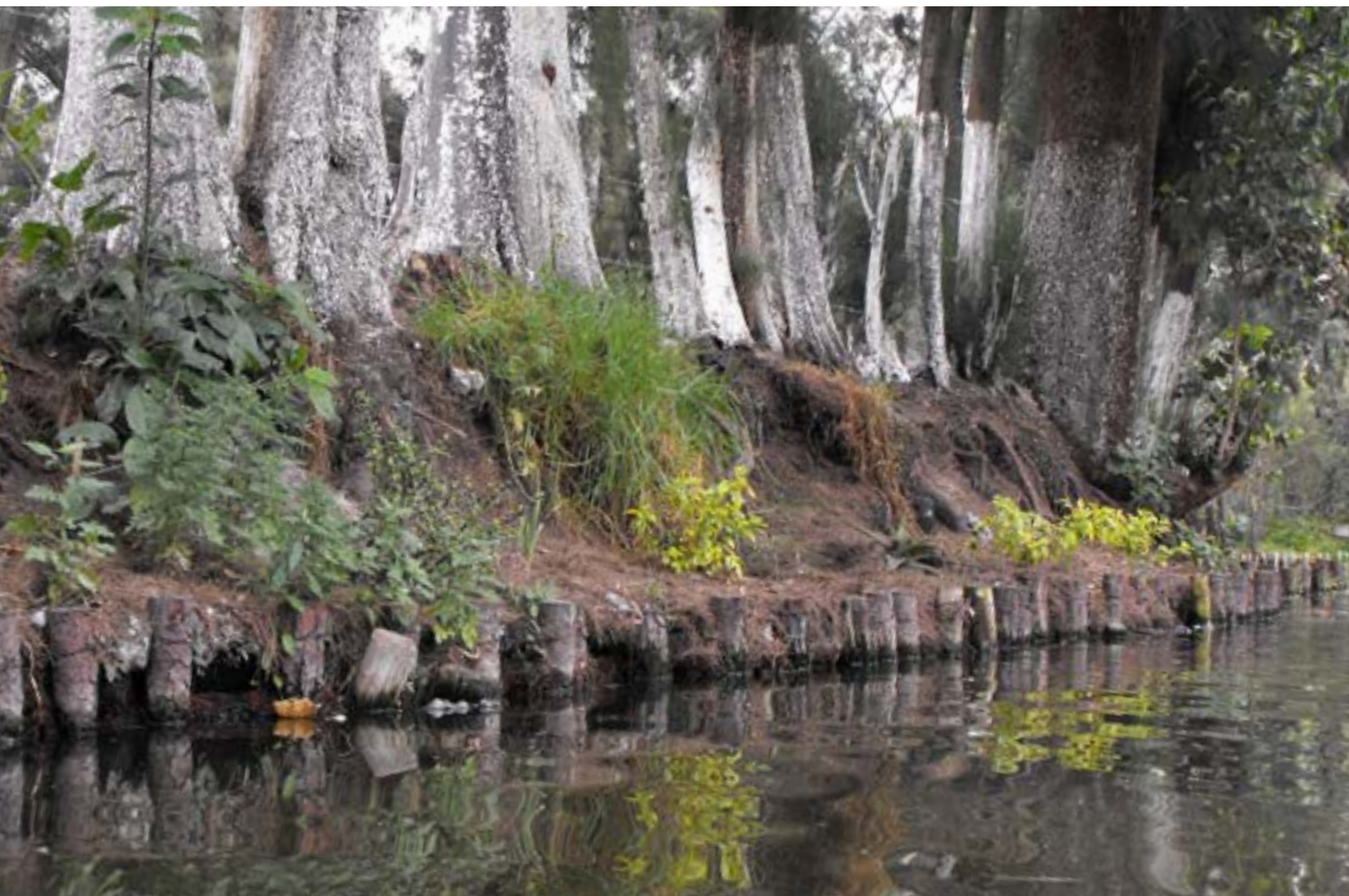
Estructura de soporte de una chinampa en Xochimilco Supporting structure of a chinampa in Xochimilco
