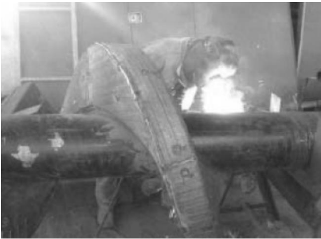
Figura 9. Eje falso agregado al tornillo sinfín; Túnel Emisor Oriente.
