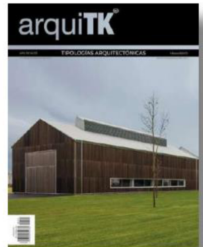
Proyecto: Norvento Enerxia S.L. Autor: Arq. Francisco Mangado Fotografía: Juan Rodríguez
