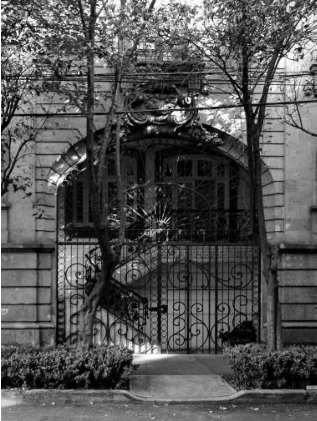
Edificio de departamentos en la calle de Tabasco núm. 133, esquina con Córdoba, en la colonia Roma. Fotografías: ism, octubre de 2010.
