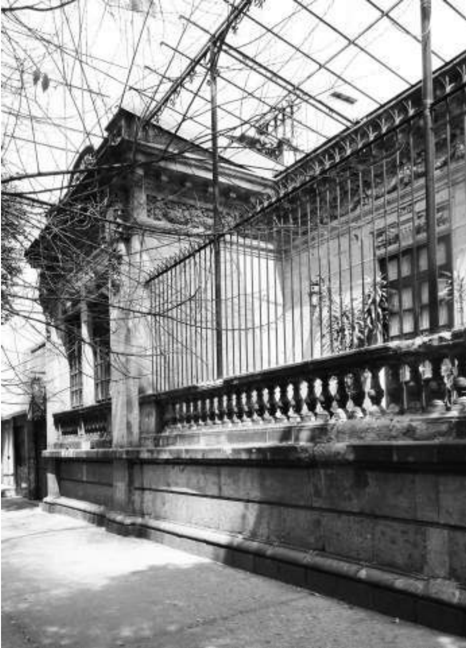
Vista exterior del palacete en Jalapa núm. 90, en la colonia Roma. Fotografía: ISM, marzo de 2012.
