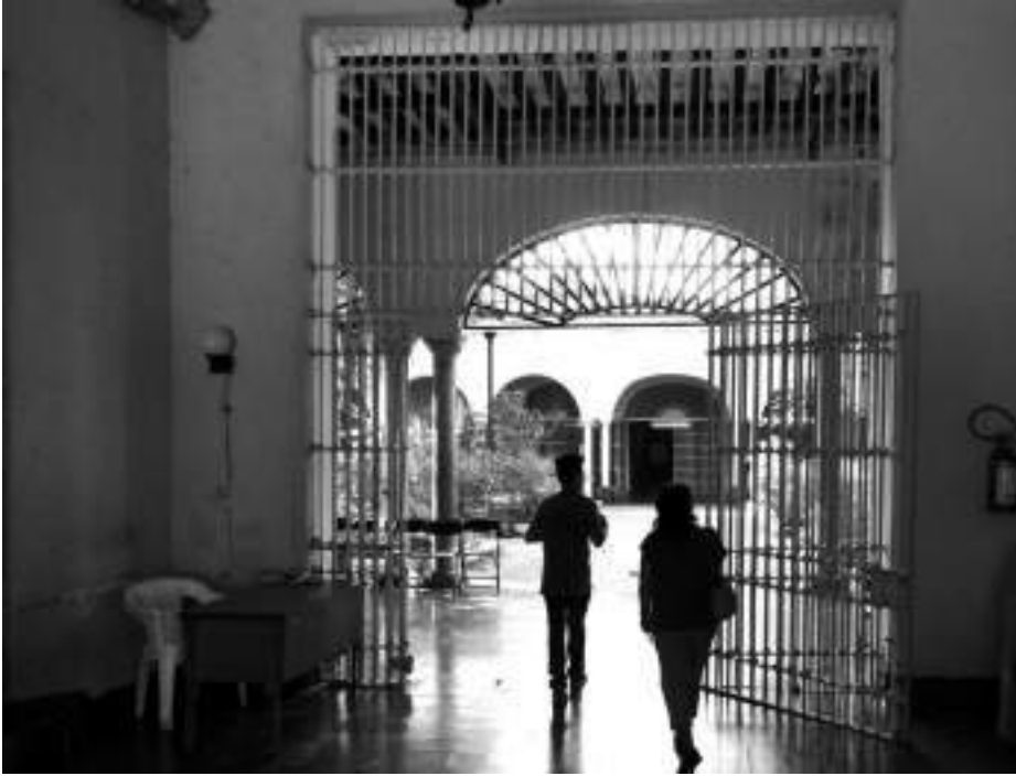
Zaguán de acceso a la antigua Penitenciaría de Mérida, con algunas alteraciones patrimoniales que serían fácilmente reversibles. Fotografía: ISM, noviembre de 2013.
