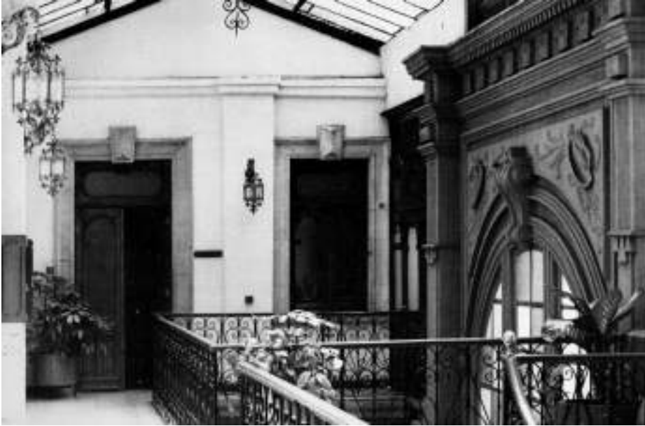
Interior del último nivel del edificio Garantías. Fuente: Francisco A.H. Schroeder Cordero, Entorno a la plaza y Palacio de Minería (México, UNAM, 1988, lámina 121).
