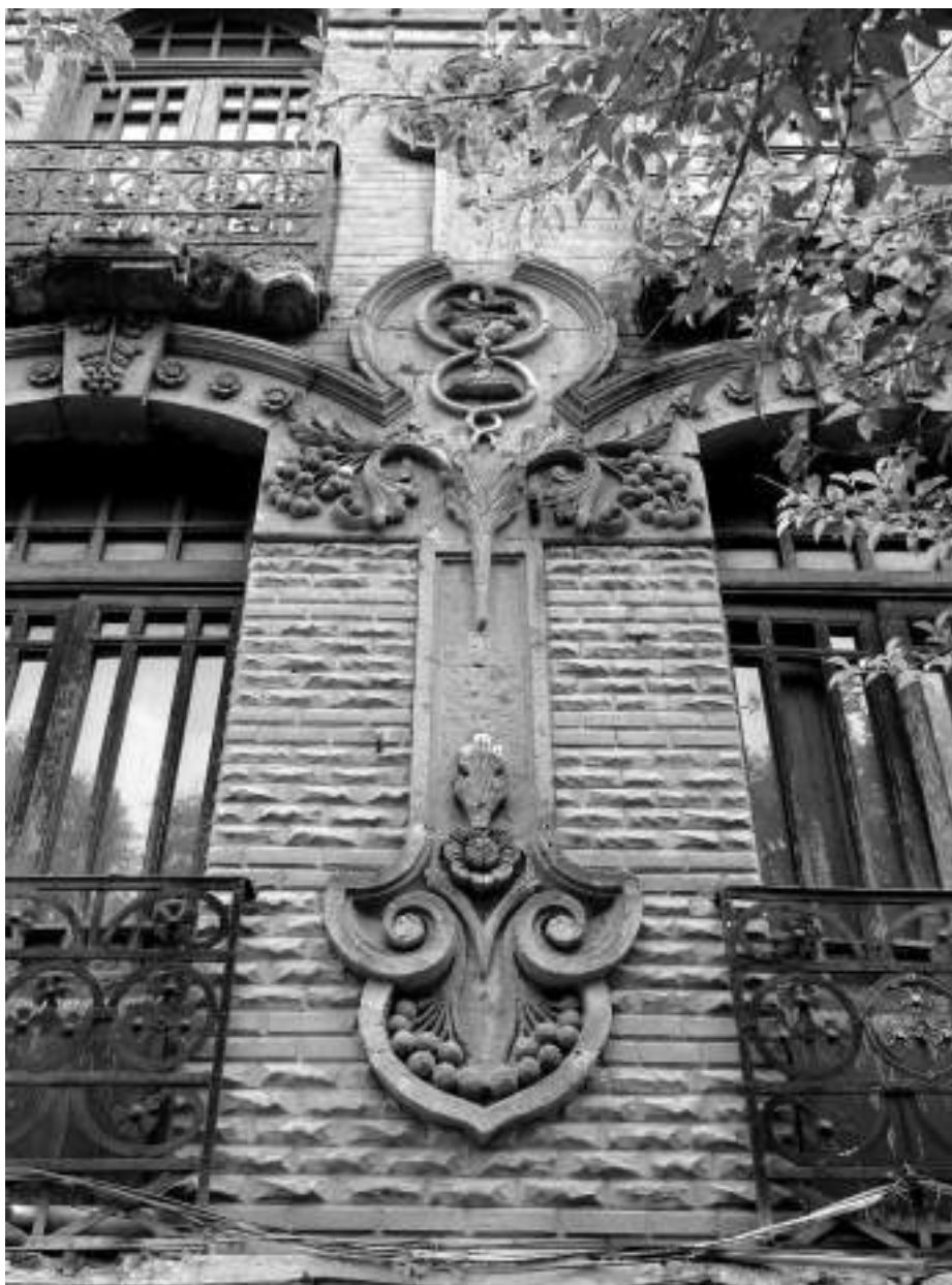
Detalles de fachada del edificio en la Avenida Álvaro Obregón núms. 45 y 47, en la colonia Roma. Fotografías: ISM, julio de 2011.
