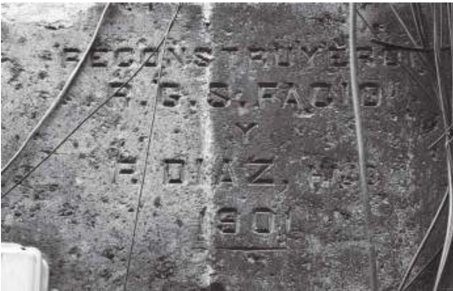
Fachada actual del antiguo palacio del Marqués del Apartado y la inscripción autoral en la planta baja de su fachada norte, donde aún se aprecian los nombres de los ingenieros: "Reconstruyeron R.G.S. Facio y P. Díaz, hijo, 1901". Fotografías: ISM, enero de 2005 y agosto de 2019, respectivamente.
