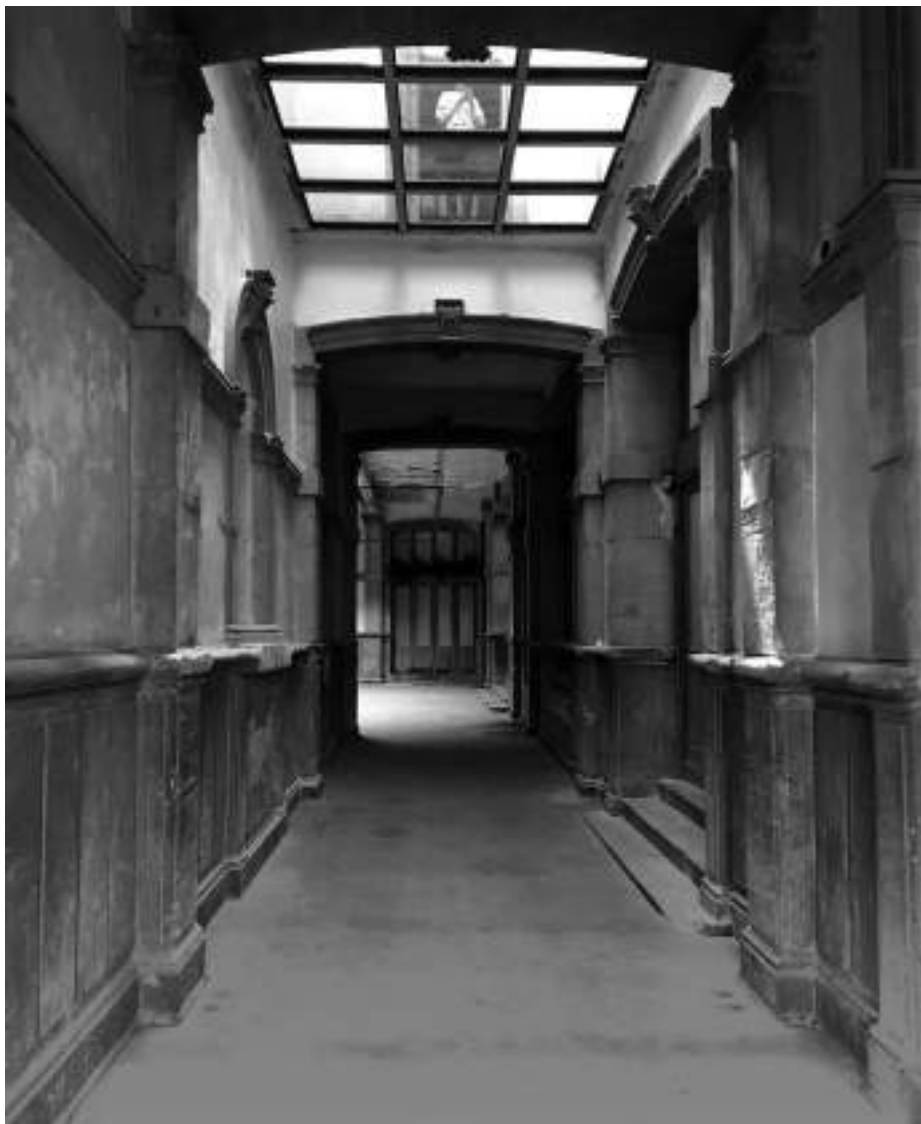
Vista desde la calle del pasaje que comunica con el patio principal. Fotografía: ISM, febrero de 2019.
