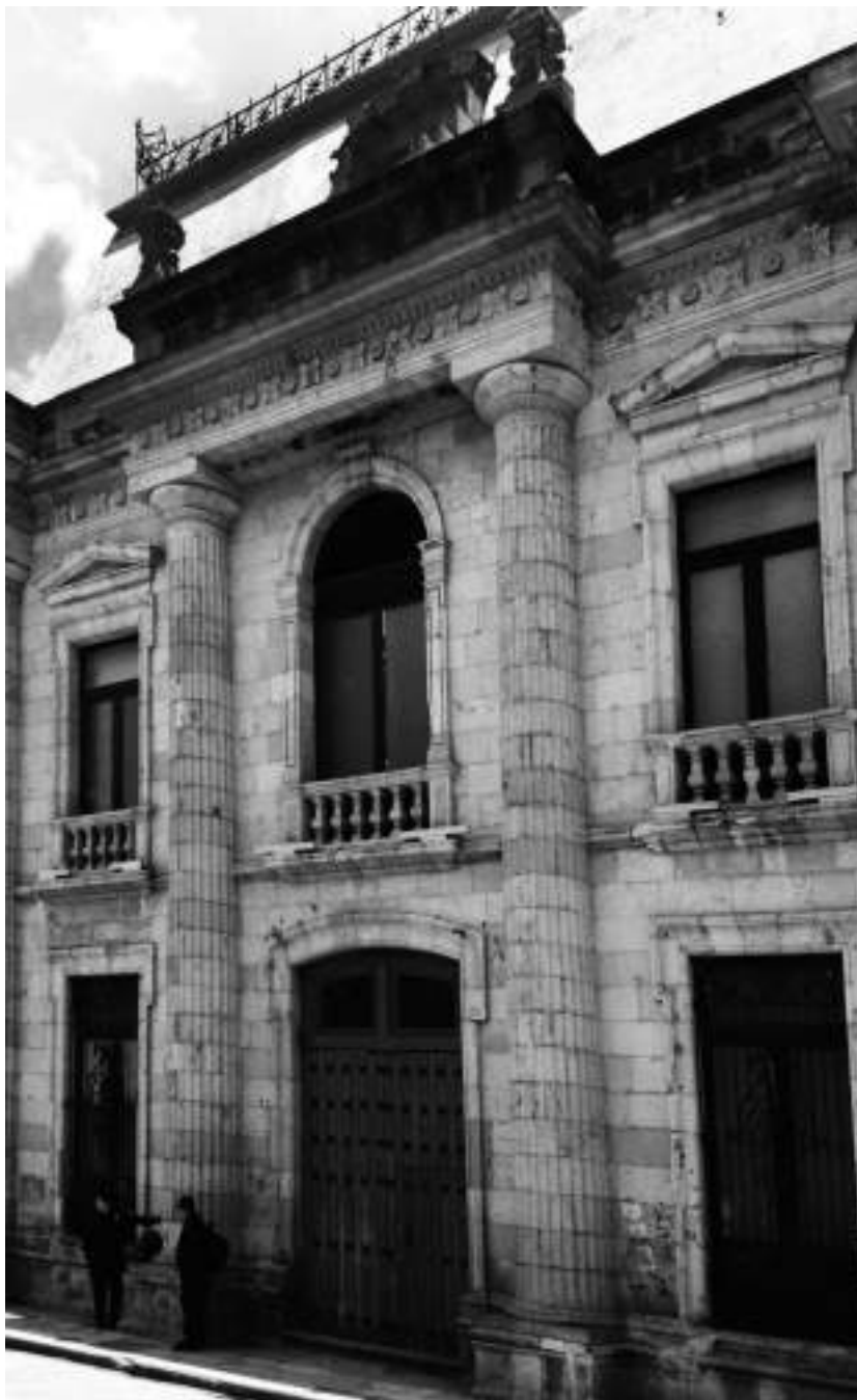
Vistas reciente de la fachada oriente del Instituto de Ciencias y Artes de Oaxaca. Fotografía: ISM enero de 2015.
