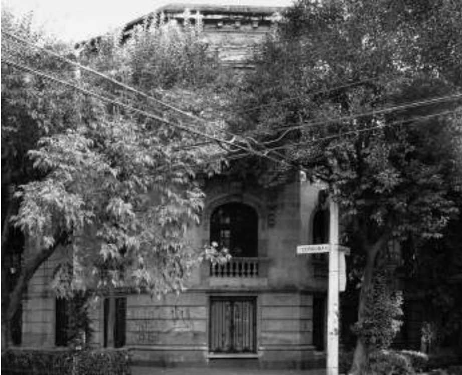
Edificio de departamentos en la calle de Tabasco núm. 133, esquina con Córdoba, en la colonia Roma. Fotografía: ISM, octubre de 2010.
