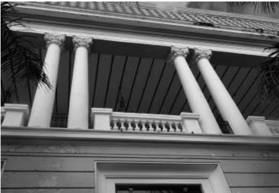
Vistas exteriores recientes del antiguo Palacio de Correos, hoy convertido en Museo de la Ciudad. Los volúmenes salientes en planta baja fueron añadidos posteriormente. Fotografías: ISM, noviembre de 2013.
