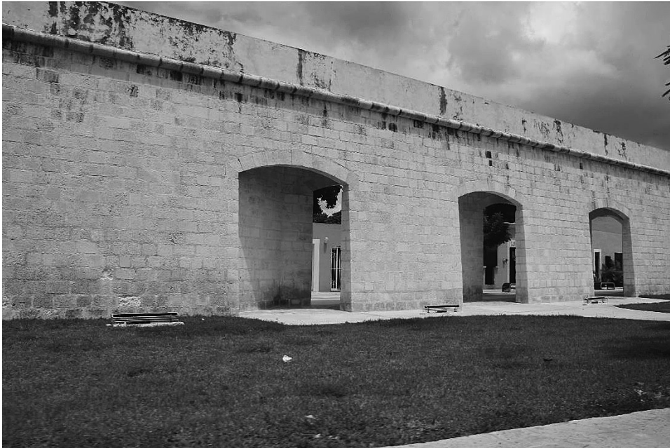
FIG. 5. Lienzo de muralla construido en 2013 con arcos no originales. Foto M. C. C. 2013.
