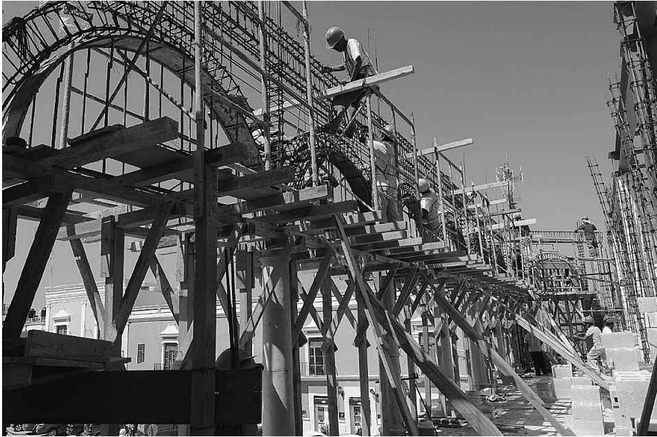
FIG. 8. Aduana en proceso de reconstrucción. Foto cortesía Arq. José Buenfil 2013.
