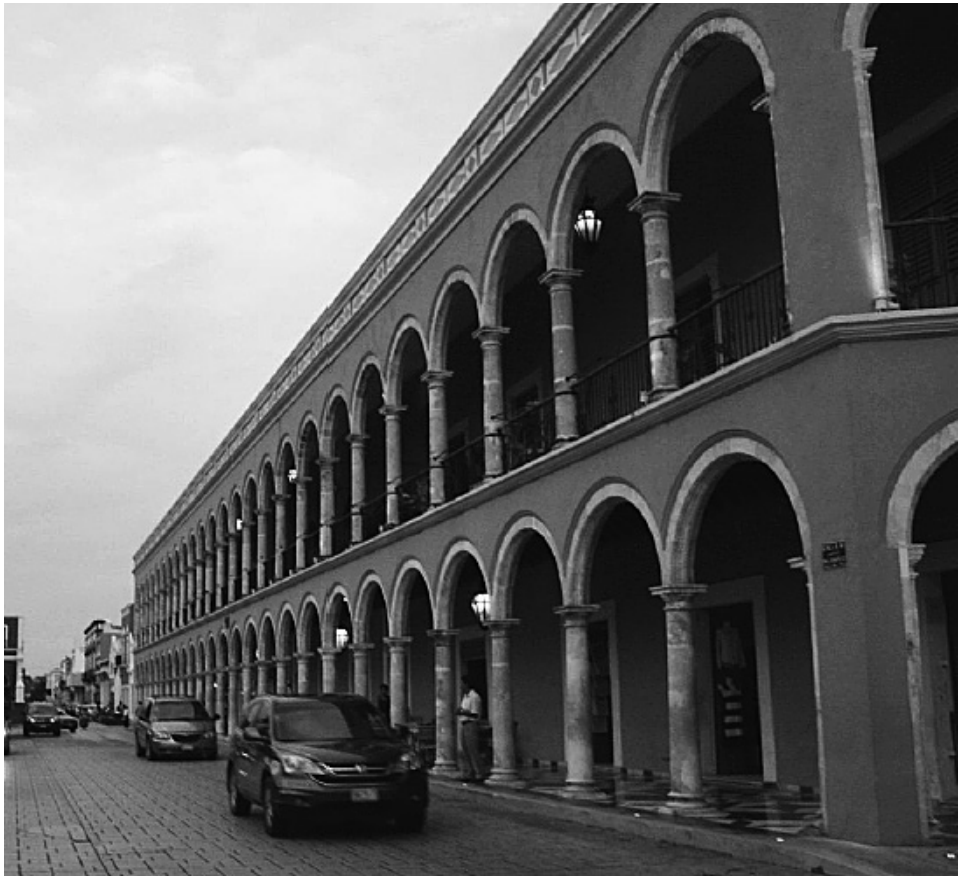
FIG. 4. Arcos de medio punto del portal Revolución que sustituyeron a los mixtilíneos. Foto M. C. C. 2013.
