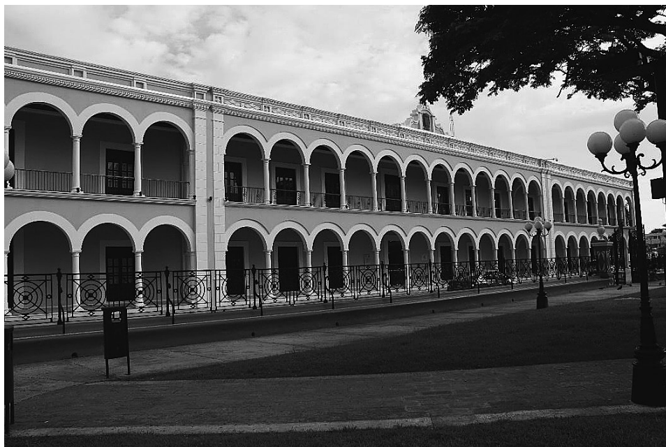
FIG. 6. Vista del conjunto reconstruido, el edificio central es la Biblioteca de Campeche y laterales, son los tramos reconstruidos recientemente. Foto M. C. C. 2015.
