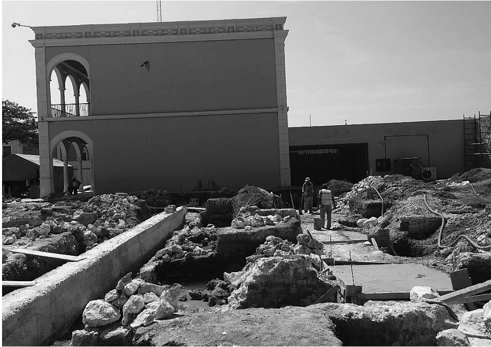
FIG. 7. Proceso de reconstrucción del costado poniente.
