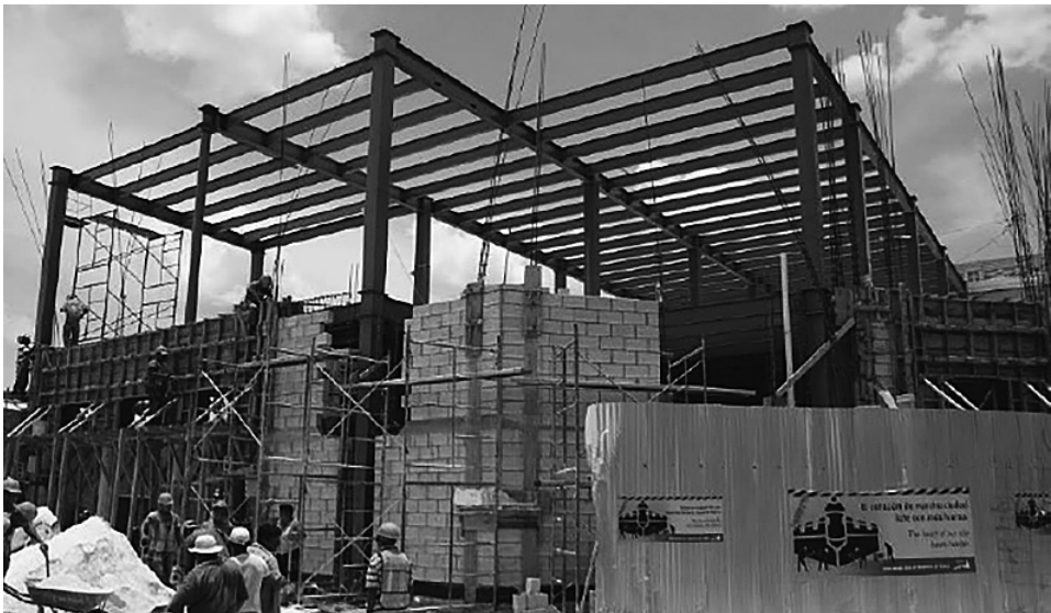
FIG. 9. Aduana en proceso de reconstrucción. Foto cortesía Arq. José Buenfil 2013.
