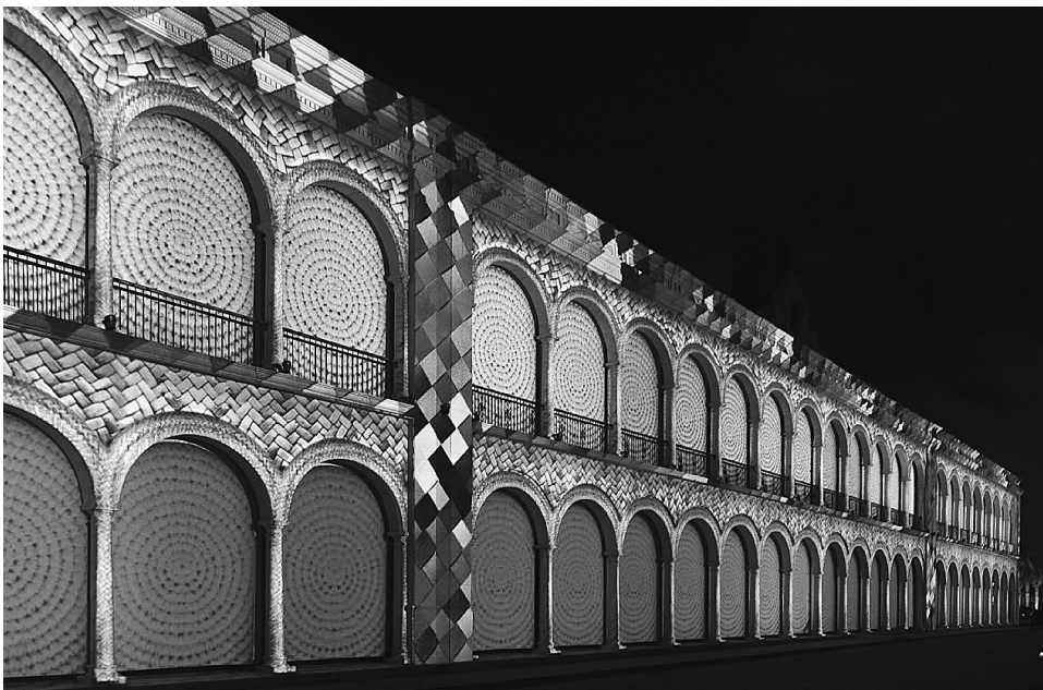
FIG. 12. Proyección de video en fachada del conjunto reconstruido. Foto M. C. C. 2015.
