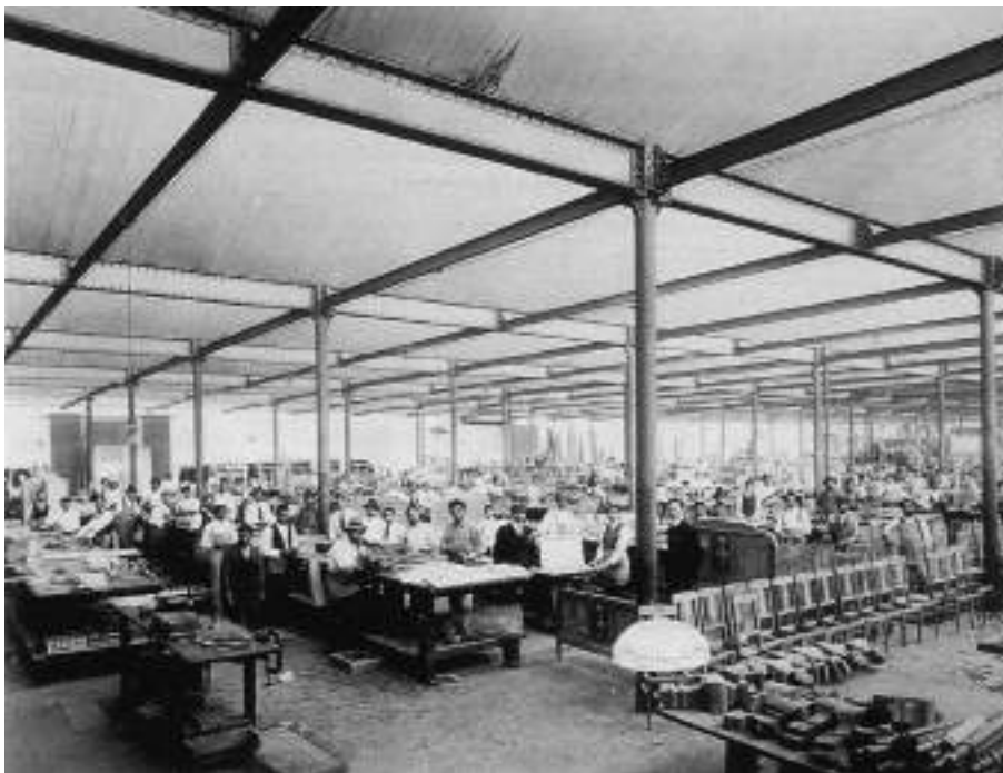
Fábrica de ebanistería en los talleres de El Palacio de Hierro. Fuente: Archivo Palacio de Hierro, s.A., en Patricia Martínez Gutiérrez, El Palacio de Hierro. Arranque de la modernidad arquitectónica en la Ciudad de México (México: Facultad de Arquitectura, Instituto de Investigaciones Estéticas, UNAM, 2005), p. 93
