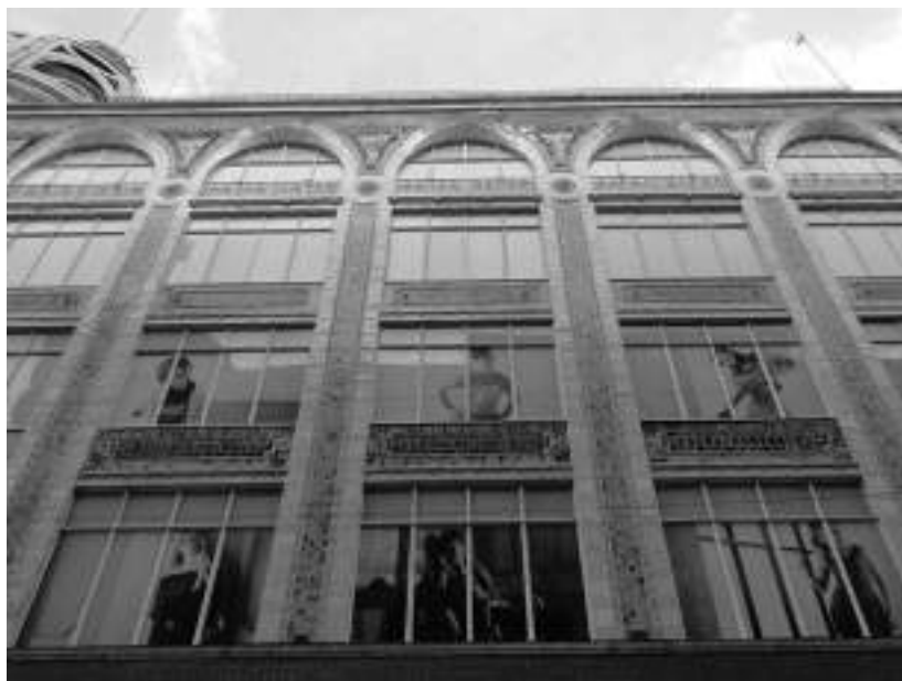
Vistas recientes de las Antiguas Fábricas Universales, hoy tienda C&A. Fotografías: ISMC, febrero y abril de 2011.
