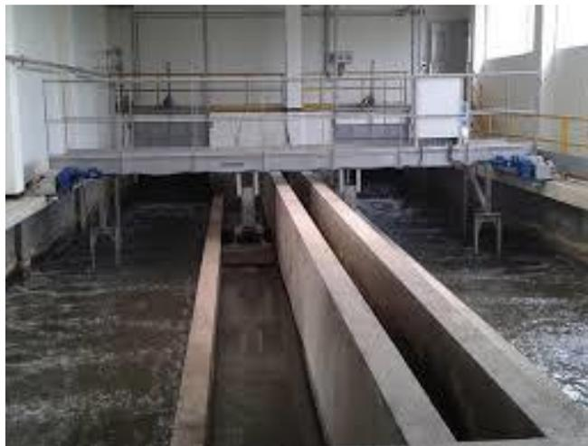
Figura 3. Desengrasado. Obtenido de <https://estruagua.com/productos/puente-desengrasador-desarenador-longitudinal-longbri/>
