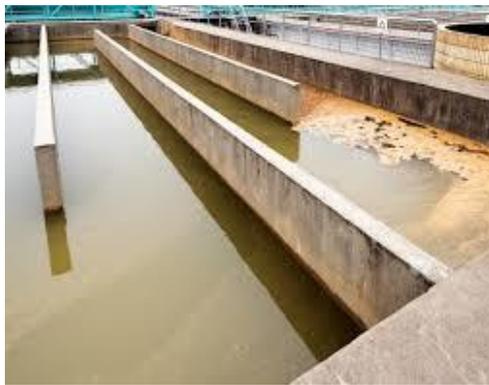
Figura 8. Tanque de contacto de cloro. Obtenido de <https://www.slideshare.net/lucasburhard/planta-aguas-servidas>
